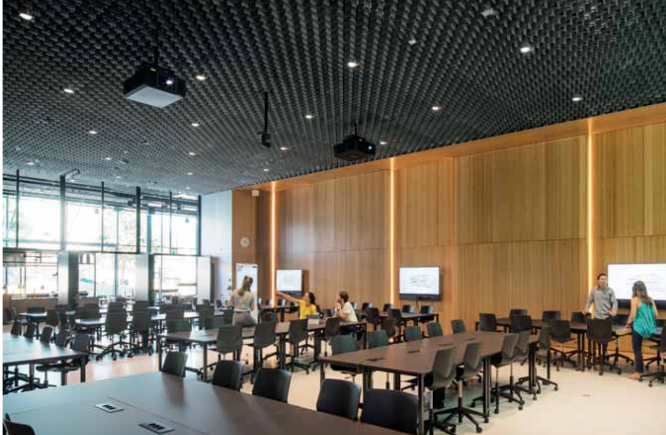
FOTO BOVEN Verschillende onderwijsruimtes hebben akoestische wanden van bamboe.
